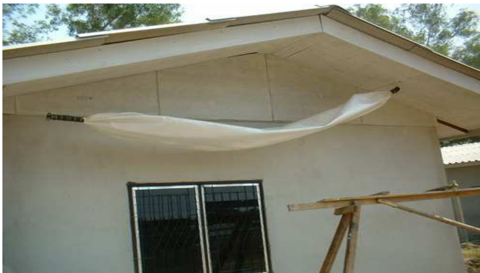
ต่อท่อนำก๊าซจากขวระบายก๊าซมายังถุกเก็บก๊าซ(ควรติดตั้งไว้ด้านบนของบ้าน)
